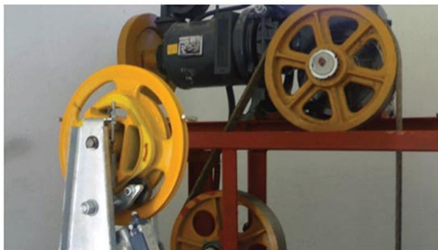
Makine daireli asansörler; Asansör tahrik makinasının asansör kuyusunun üzerinde teşkil edilmiş bir oda içerisinde bulundurulduğu asansör modelidir. Bu şekilde inşa edilen asansör türleri; insan asansörleri, yük asansörleri, araç asansörleri, sedye asansörleri, servis asansörleri gibi taşıma amaçlarına göre sınıflandırılabilirken, kontrol tarzına göre de çift hızlı, VVF hız kontrollü olarak sınıflandırılabilirler.
